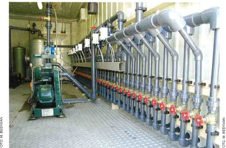
Verzamelcontainer, waar onttrekkingen samenkomen (manifold).
